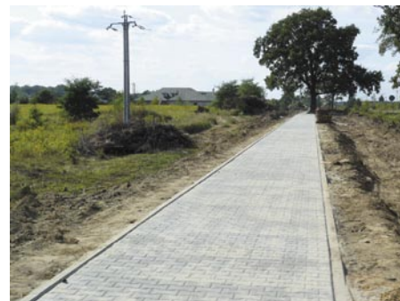
Chodnik w Sierdach i Rajszewie, na odcinku do ul. Golfowej
