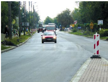
Tak Modlińska wyglądała po pierwszym położeniu nakładki asfaltowej
