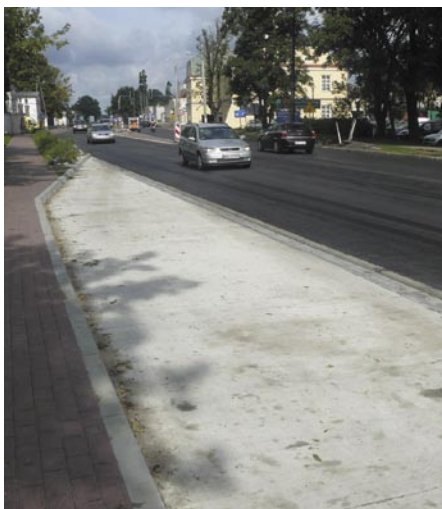
W trakcie remontu wykonano nowe zatoki autobusowe
