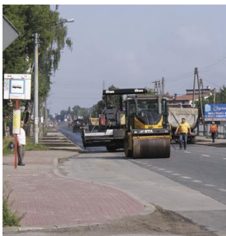
Prace modernizacyjne drogi rozpoczęto na granicy Jabłonna i Warszawy
