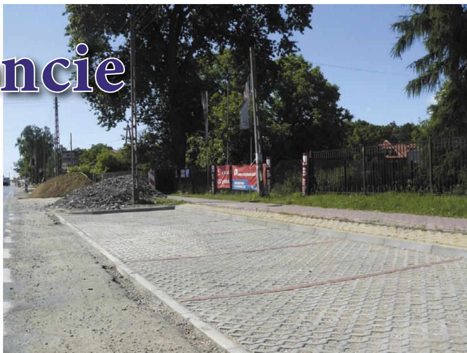
Wzdłuż ulicy Modlińskiej powstały parkingi oraz rowy na wody opadowe
