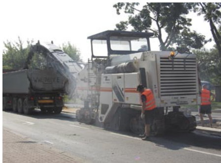
Starą nawierzchnię drogi zerwano i zastąpiono nową nakładką
