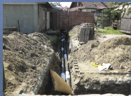
Remont sieci przesyłowej centralnego ogrzewania w szkole podstawowej
