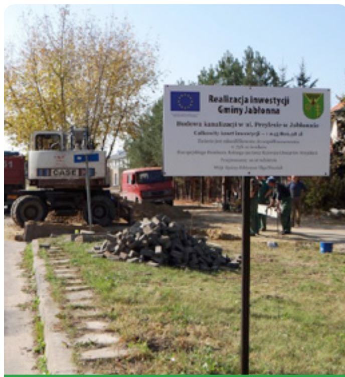
Budowa kanalizacji w ul. Przylesie
