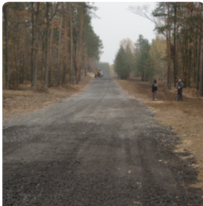
Ulica Jaśminowa w trakcie budowy
