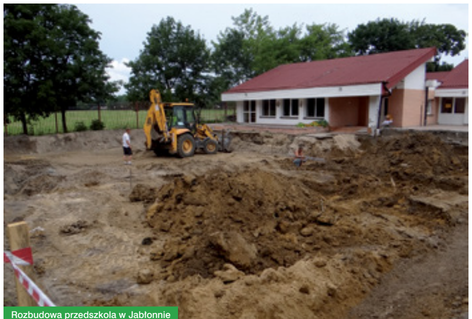
Rozbudowa przedszkola w Jabłonie
