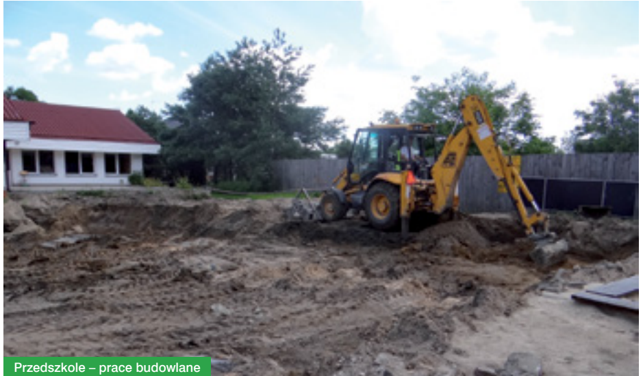
Przedszkole – prace budowlane
